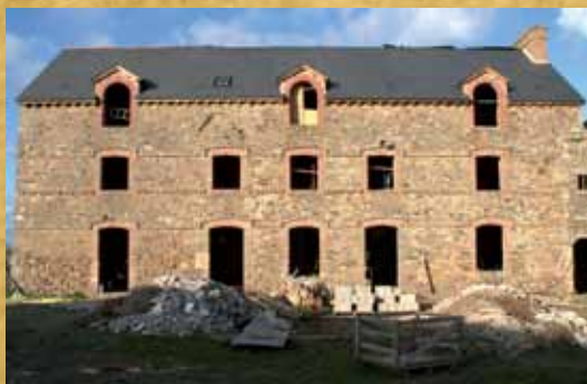
Réhabilitation en éco construction
